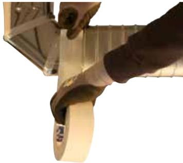
Bild 67: Abdichten mit Kaltdichtband
