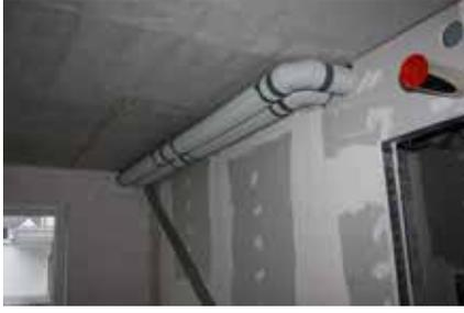
Bild 85: Außen- und Fortluft mit Kombigitter außen
