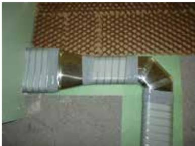
Bild 73: Verlegung in Dämmebene auf Dämmstreifen
