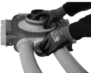
Bild 40: Anschlussstutzen verschließen
