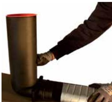
Bild 68: Verbindung zu Umlenkstücken
