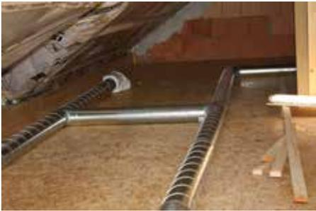
Bild 81: Spiralfalzrohr im Spitzboden
