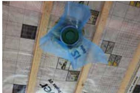
Bild 84: Anschlusschalldämpfer in Holzbalkendecke
