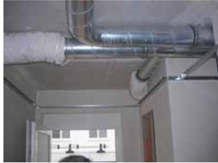
Bild 80: Spiralfalzrohr in abgehängter Decke
