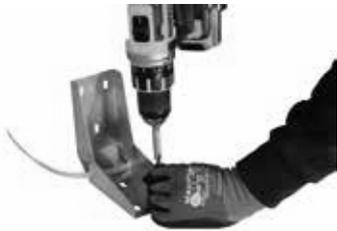
Bild 37: Winkelblech positionieren
