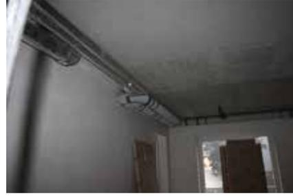
Bild 86: Separat Außen- und Fortluft mit IGC-Gitter
