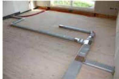
Bild 72: In der Dämmebene des Estrichs
