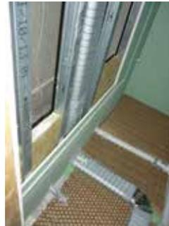
Bild 74: In der Dämmebene mit Estrich-Waben
