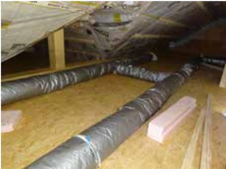
Bild 83: Gedämmtes Spiralfalzrohr
