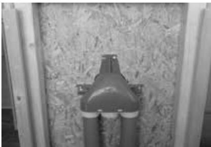
Bild 48: Befestigung an Holzständerwand (Beispiel)
