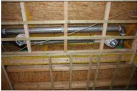
Bild 79: Spiralfalzrohr in Holzdecke
