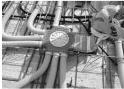
Bild 43: Horizontalverteiler auf Filigrandecke
