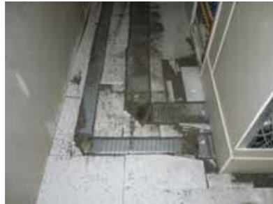
Bild 76: In Dämmebene mit Wabenschüttung und Abdeckung
