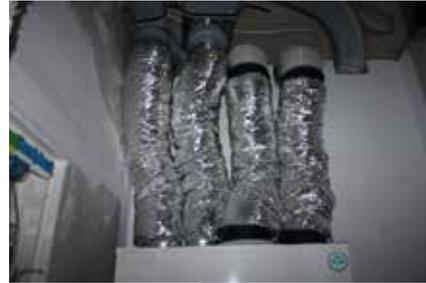
Bild 88: Leitungen an SCD-Schalldämpfer montiert
