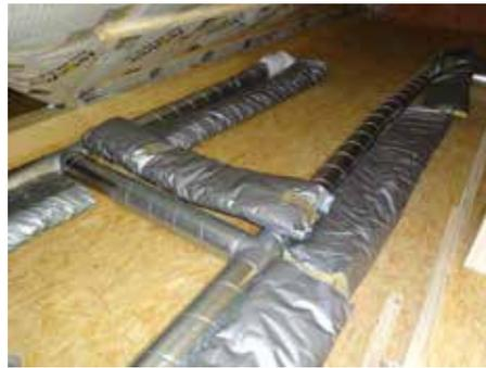
Bild 82: Vorbereitung der Dämmung im Spitzboden
