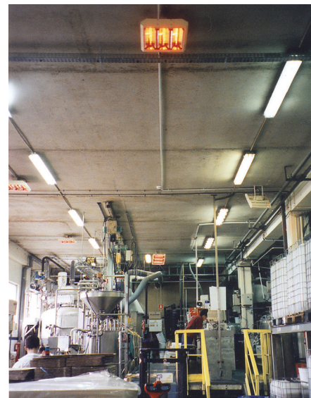
IRCF je často instalován ve velkých skladech. Poskytuje okamžité a efektivní teplo.
