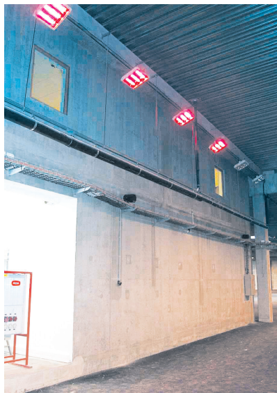
IRCF lze namontovat na zeď nebo na strop a je vhodný do budov, které jsou používány ojedinelé, jako je tato startovní oblast koleje.
