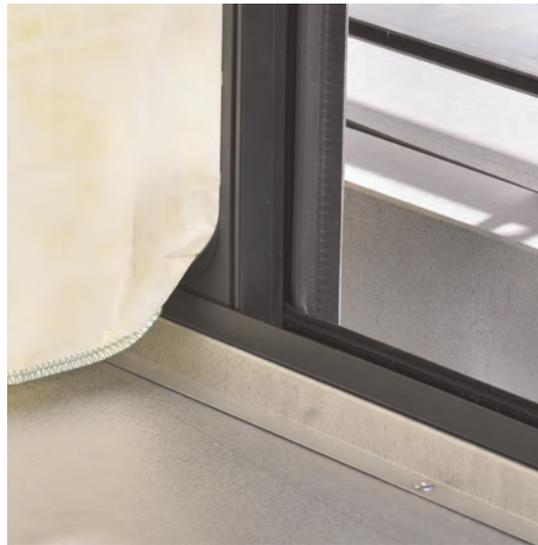
Vérifier que le profilé flexible gris sur le cadre métallique vertical qui maintient les filtres ne présente pas d'usure ni de dommage et que le profilé souple gris est toujours suffisant pour éviter toute fuite d'air entre la porte d'inspection fermée et le cadre qui maintient les filtres.
