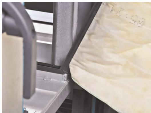
Vérifier que les filtres sont poussés dans la position à laquelle les cadres verticaux de la fermeture des filtres à poches sont complètement fermés contre les bords souples verticaux dans la centrale de traitement d'air pour éviter des fuites d'air.
