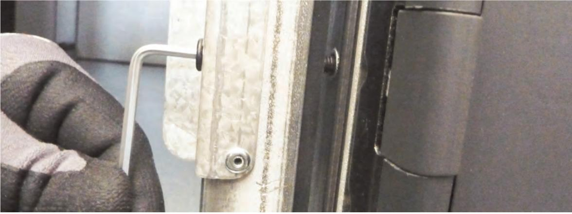
Insérer la vis dans le trou et serrer la vis. Il pourrait être utile de tirer les sections ensemble complètement avant de serrer les vis.
