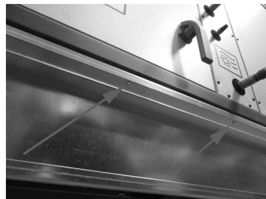
Undersiden av den monterte bunnrammen. Skruene vil ikke være synlige når du ser på aggregatet.
