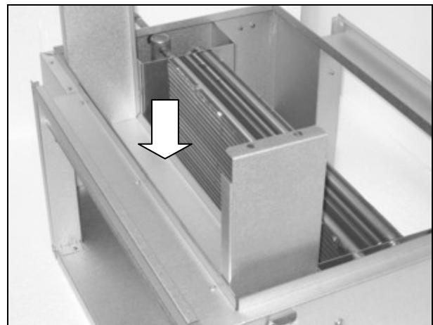
**5.** Skjut i droppavskiljare/ Push in the droplet eliminator/ Tropfabscheider einschieben.
