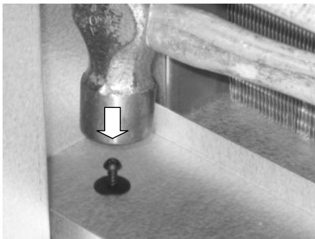
**5.**Skjut i droppavskiljare/ Push in the droplet eliminator/ Tropfabscheider einschieben.
