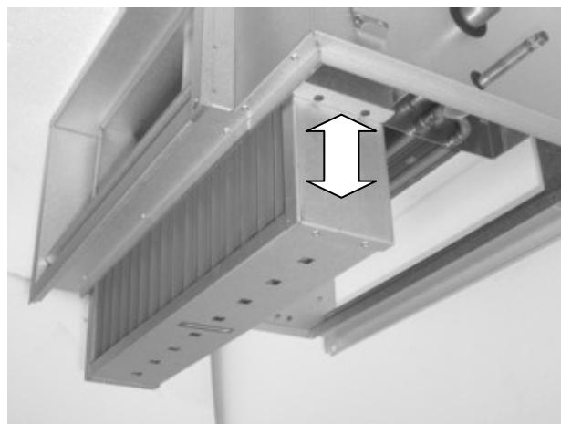
**3.**Fixera hållare runt droppavskiljare/ Secure the holder around the droplet eliminator/ Halterung um den Tropfabscheider fixieren.
